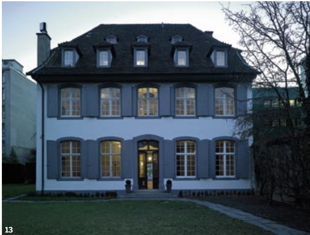
13: Die axialsymmetrische gartenseitige Fassade. Das Erdgeschoss wurde um 1740 erstellt und während den 1780er Jahren aufgestockt.
